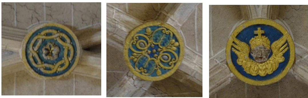
Fotografías 80, 81 y 82: Claves de la bóveda Nave 4, D1, D2, D3. Fotografías del autor.
