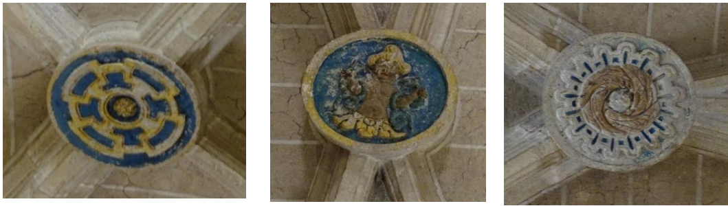
Fotografías 92, 93 y 94: Claves de la bóveda Nave 4, I4, I5, I6. Fotografías del autor.
