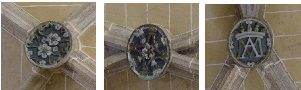
Fotografías 60, 61 y 62: Claves de la bóveda Nave 2, I4, I5, I6. Fotografías del autor.
