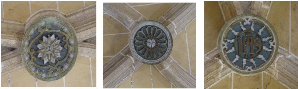
Fotografías 57, 58 y 59: Claves de la bóveda Nave 2, I1, I2, I3. Fotografías del autor.
