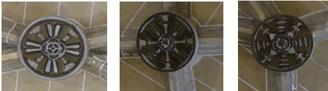
Fotografías 30, 31 y 32: Claves de la bóveda Nave 1, D1, D2, D3. Fotografías del autor.
