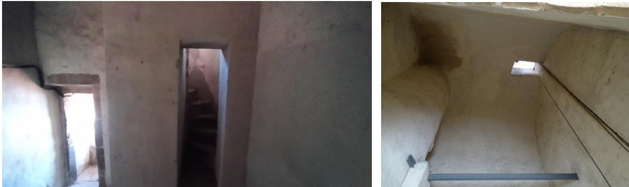
Fotografías 141 y 142: Vista desde el interior de la estancia, puerta de entrada a la estancia y puerta de subida. Vista de la bóveda de cañón con hueco en la bóveda para el sonido de las campanas, cables de iluminación de la torre y sonido del reloj. Fotografías del autor.
