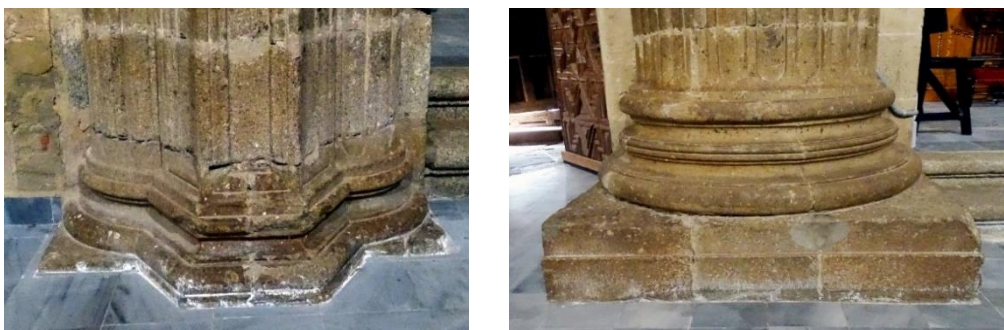
Fotografías 24 y 25: Bases de los pilares que soportan las naves de salón. Izquierda pilar de la nave 1-2 y a la derecha pilar de la nave 2-3. Fotografías del autor.
