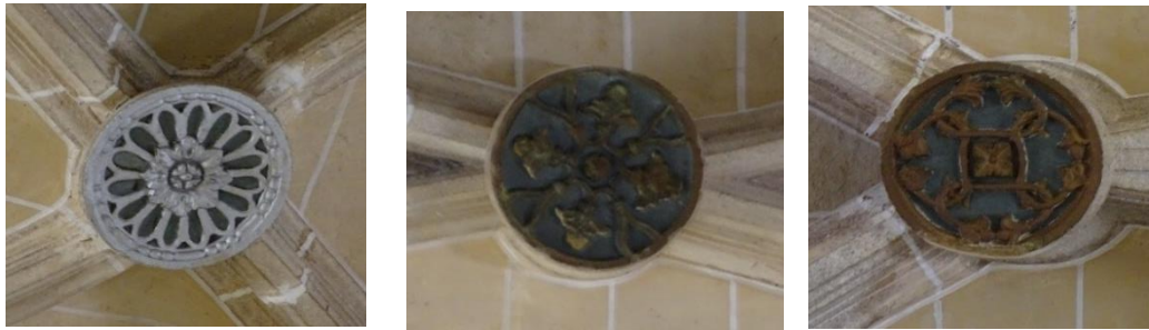
Fotografías 76, 77 y 78: Claves de la bóveda Nave 3, I4, I5, I6. Fotografías del autor.
