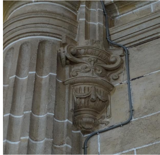
Fotografías 126 y 127: Una ménsula apoyada en paredes, situada en la esquina y la otra situada en pilar y pared. Situadas por debajo de una gran moldura que recorre el coro. Fotografías del autor.
