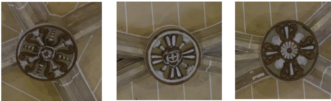
Fotografías 42, 43 y 44: Claves de la bóveda Nave 1, I4, I5, I6. Fotografías del autor.
