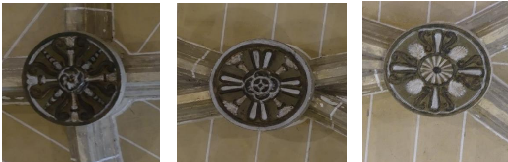
Fotografías 33, 34 y 35: Claves de la bóveda Nave 1, D4, D5, D6. Fotografías del autor.
