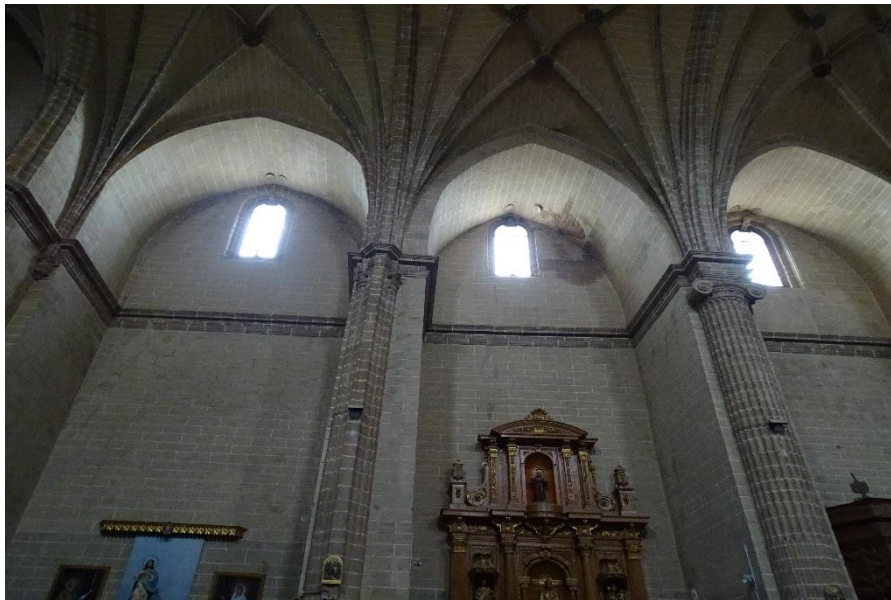
Fotografía 104: Bóvedas ojivales de dos capillas y del crucero (puerta del evangelio), conectando con las bóvedas de crucería. Fotografías del autor.
