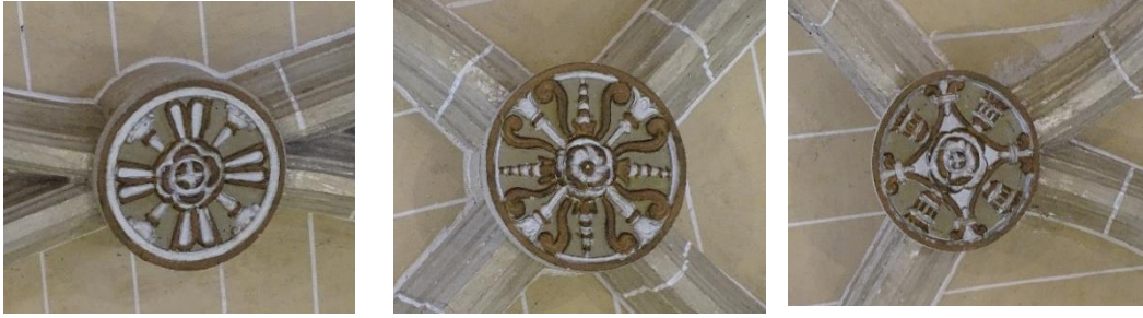
Fotografías 39, 40 y 41: Claves de la bóveda Nave 1, I1, I2, I3. Fotografías del autor.
