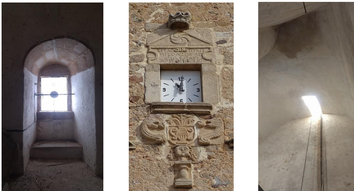
Fotografías 143, 144 y 145: Vistas del reloj desde el interior de la estancia, vista desde el exterior (atrio) y bóveda de cañón con hueco de cableado.
