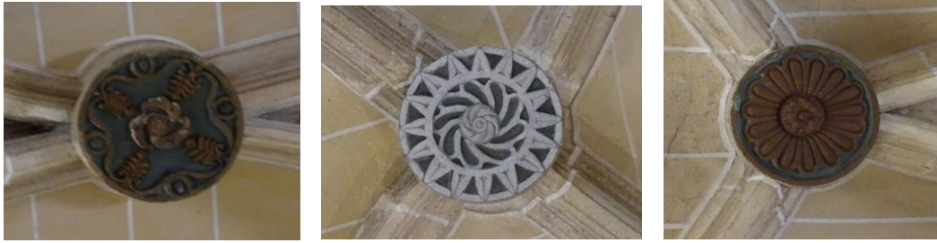
Fotografías 73, 74 y 75: Claves de la bóveda Nave 3, I1, I2, I3. Fotografías del autor.
