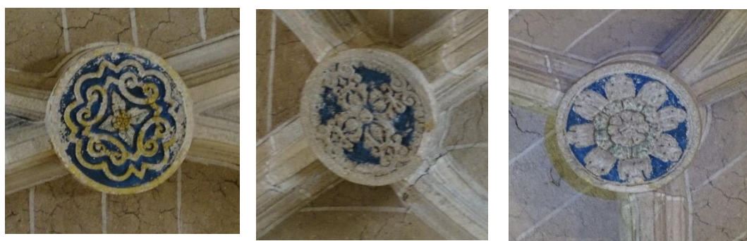
Fotografías 89, 90 y 91: Claves de la bóveda Nave 4, I1, I2, I3. Fotografías del autor.
