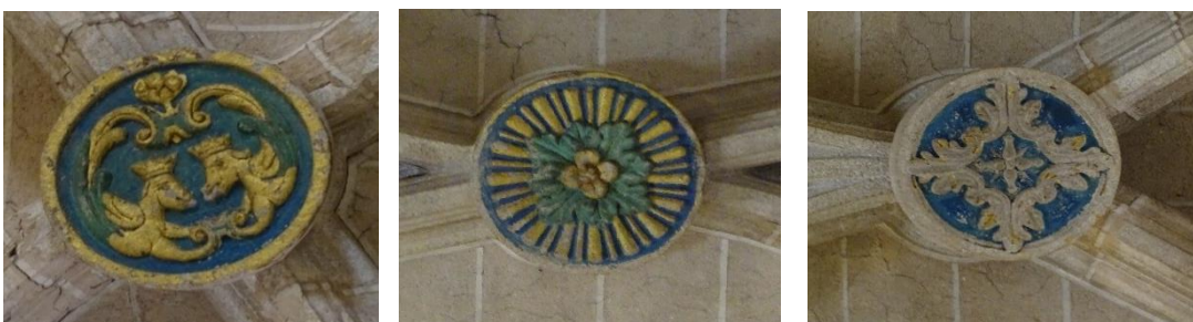
Fotografías 83, 84 y 85: Claves de la bóveda Nave 4, D4, D5, D6. Fotografías del autor.
