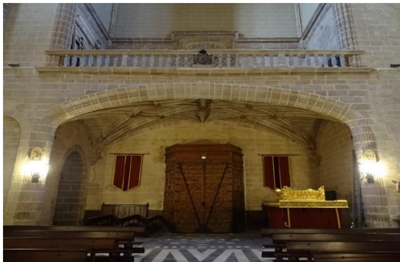
Fotografía 19: Sotocoro con su arco escarzano soportando el coro y apoyo de la bóveda. Fotografía del autor.
