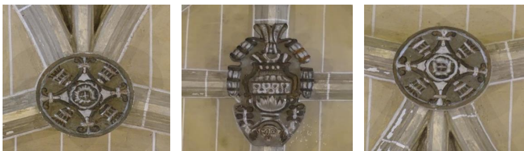
Fotografías 36, 37 y 38: Claves de la bóveda Nave 1, E1, E2 (Clave principal), E3. Fotografías del autor.
