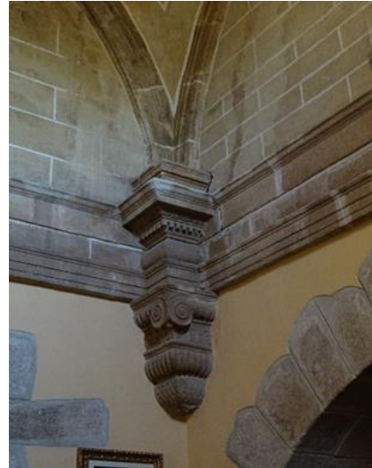
Fotografías 6 y 7: Apoyos suspendidos de las bóvedas en ménsula y muro. Ménsula del ábside y apoyo de la sacristía. Fotografías del autor.
