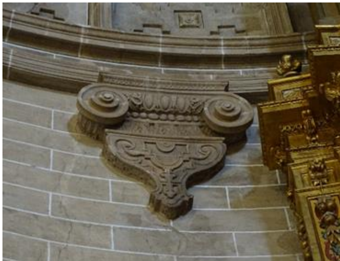
Fotografías 6 y 7: Apoyos suspendidos de las bóvedas en ménsula y muro. Ménsula del ábside y apoyo de la sacristía. Fotografías del autor.
