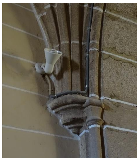
Fotografía 21: Ménsula apoyada en la pared de entrada en la sala y al muro del arco ojival. Fotografía del autor.
