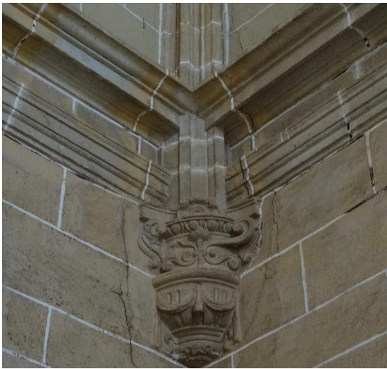
Fotografías 126 y 127: Una ménsula apoyada en paredes, situada en la esquina y la otra situada en pilar y pared. Situadas por debajo de una gran moldura que recorre el coro. Fotografías del autor.
