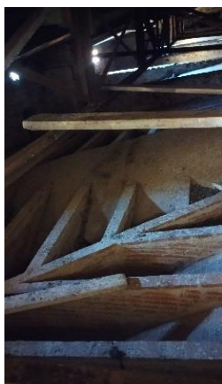
Fotografías 138, 139 y 140: Vista de la estructura de la cubierta situada en la parte superior de las bóvedas de las naves. Estructura metálica, para proteger las bóvedas de las naves, tras el derrumbe de una de ellas en abril de 1900. Fotografías del autor.
