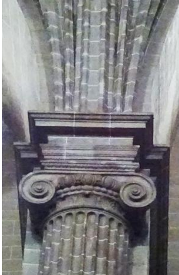
Fotografías 4 y 5: Apoyo continuo de las bóvedas en el capitel del pilar. Fotografías del autor.
