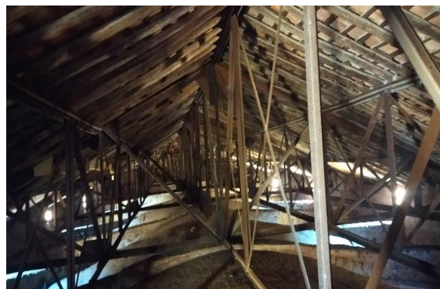
Fotografías 138, 139 y 140: Vista de la estructura de la cubierta situada en la parte superior de las bóvedas de las naves. Estructura metálica, para proteger las bóvedas de las naves, tras el derrumbe de una de ellas en abril de 1900. Fotografías del autor.
