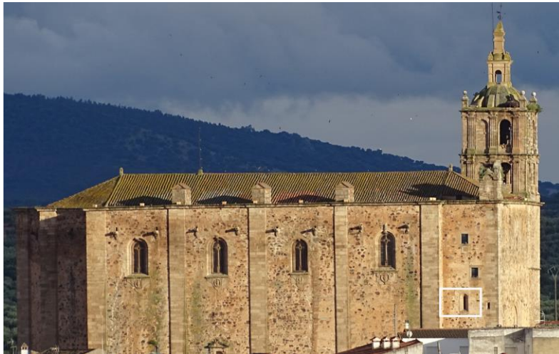
Fotografía 111: Vista de la subida a la cubierta, el recuadro blanco indica lugar de paso al coro donde observamos la siguiente bóveda. Fotografía del autor.
