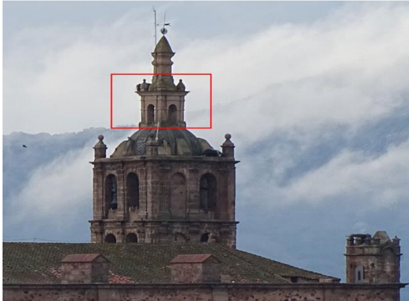
Fotografía 151: Vista de la torre indicando la bóveda no documentada. Elaboración propia.
