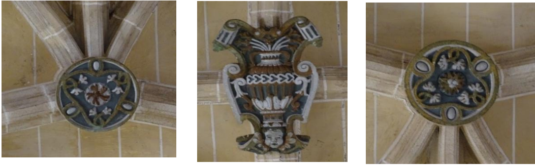
Fotografías 54, 55 y 56: Claves de la bóveda Nave 2, E1, E2 (Clave principal), E3. Fotografías del autor.
