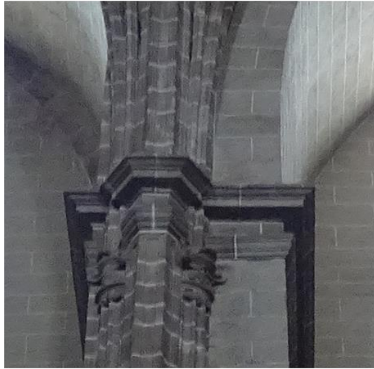
Fotografías 4 y 5: Apoyo continuo de las bóvedas en el capitel del pilar. Fotografías del autor.
