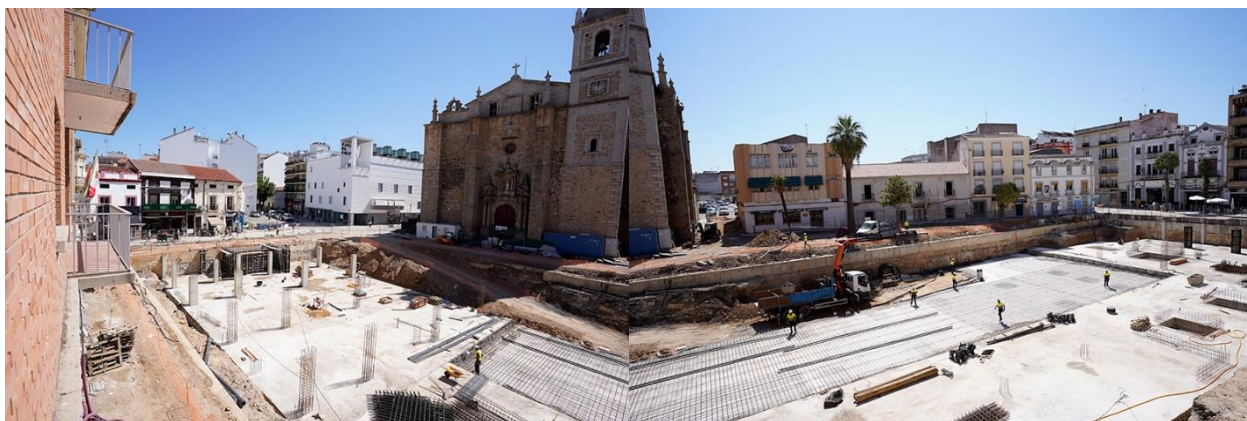
Construyéndose los muros y pilares de la planta inferior de la Plaza el 12 de julio de 2024 (Foto: Facebook Ayuntamiento de Don Benito)
