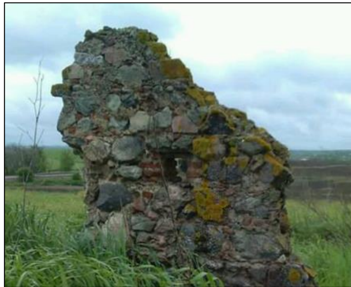
Restos de la torre de la Esparragosa.
