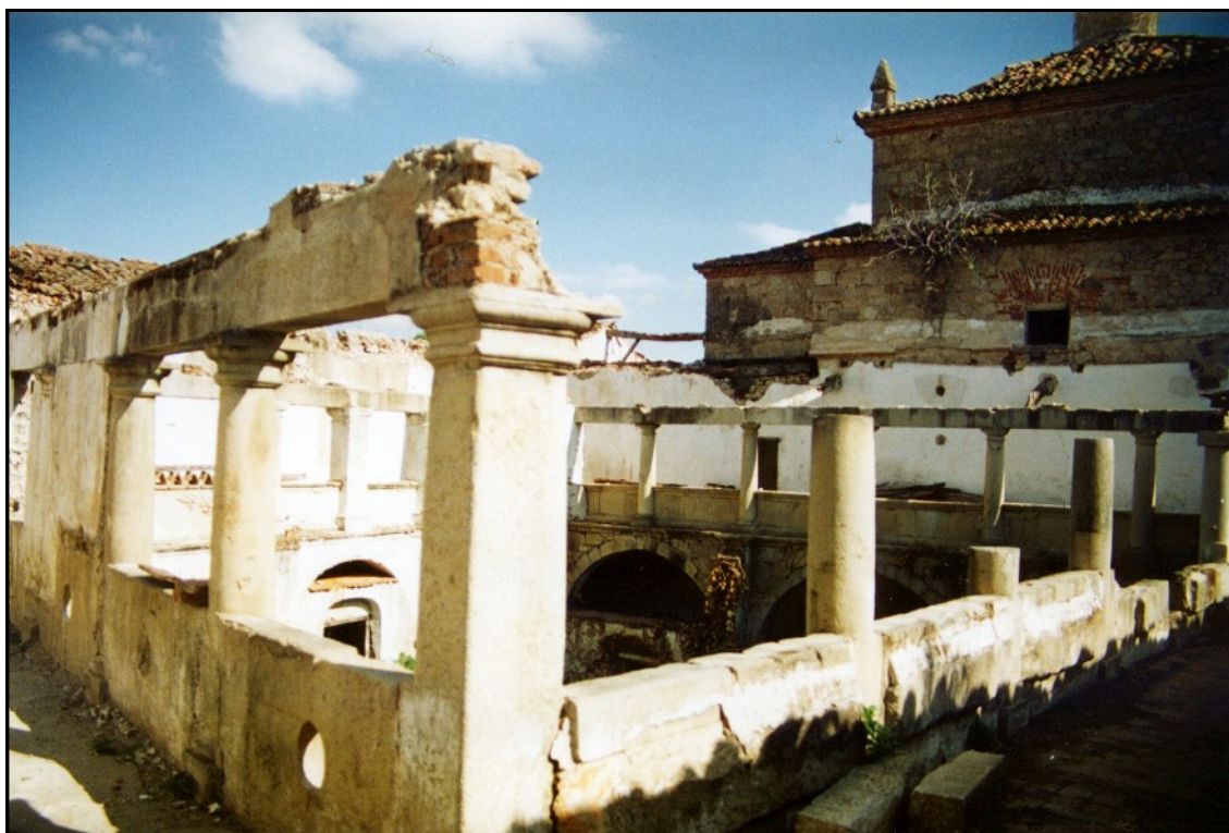
Imagen 24: El Claustro antes de las obras.
