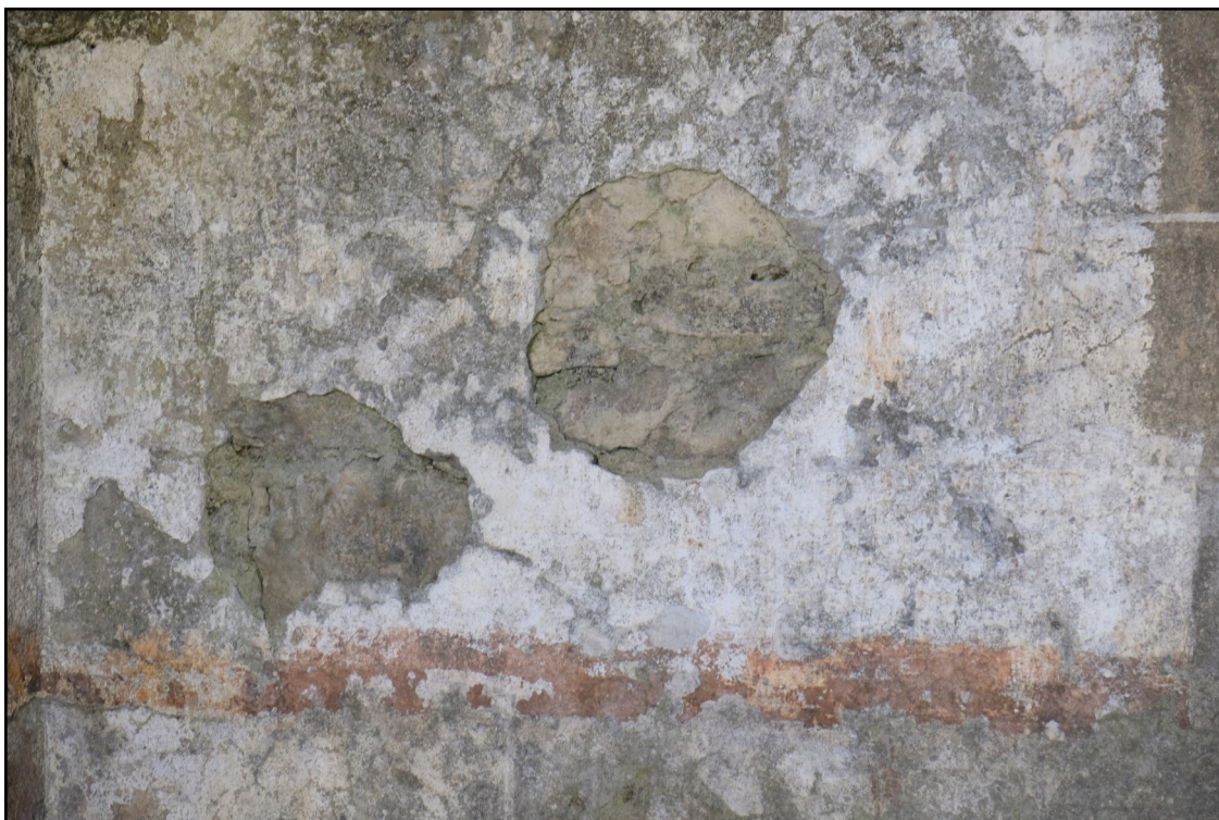
Imagen 8: Detalle de los esgrafiados
